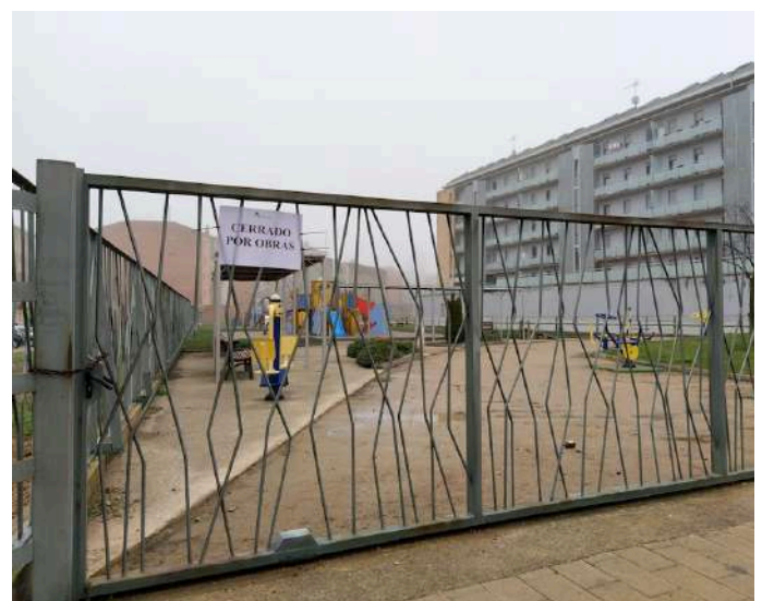
Parque infantil de la avenida Ponferrada cerrado por obras desde el mes de octubre.
