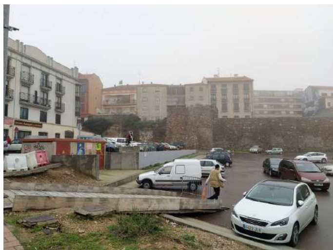
Estado actual del aparcamiento del Melgar a falta de ejecución de la segunda fase de embellecimiento.
